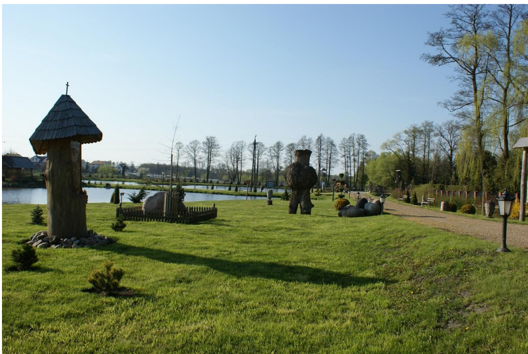
Zdjęcie zbiorników obiektu małej retencji – ujęcie na kapliczkę i Dąb Papieski
